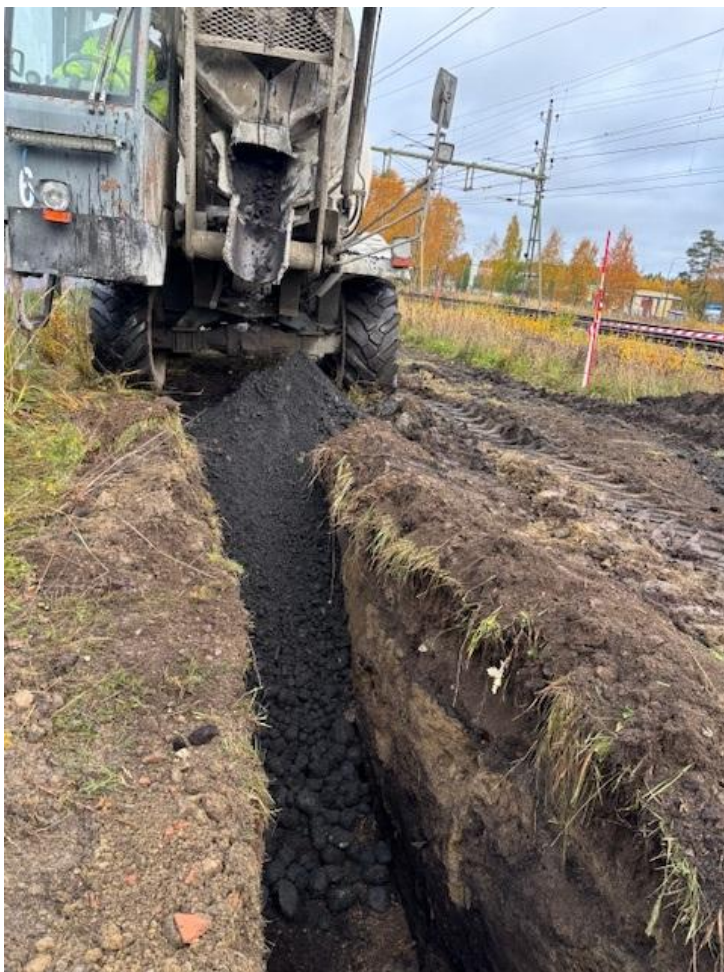
Figur 3.1. Foto på installation av barriär i Bräcke. Här läggs jorden med inblandade kolpartiklar tillbaka. Fotograf Say Svanström, Liljemark Consulting.
